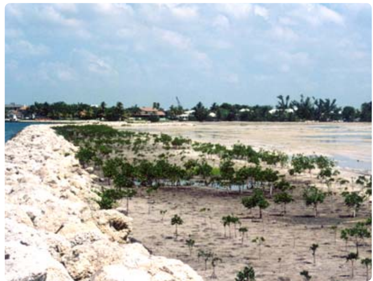
Mangrove Planter & Riprap
